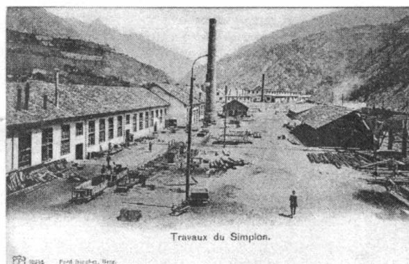
Brigue: vue des bâtiments d'entretien pour le percement du tunnel
